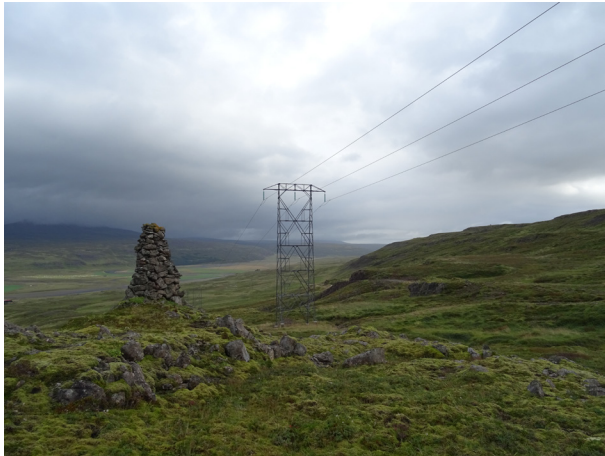
Prestavarða 014, horft til norðausturs.
